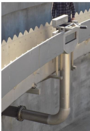
Zdjęcie 7 „Komora boczna cz. pływ. na Oczyszczalni Ścieków w Jaworznie”.
