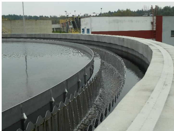
Zdjęcie 13 „Koryto przelewowe na Oczyszczalni Ścieków w Jaworznie”.
