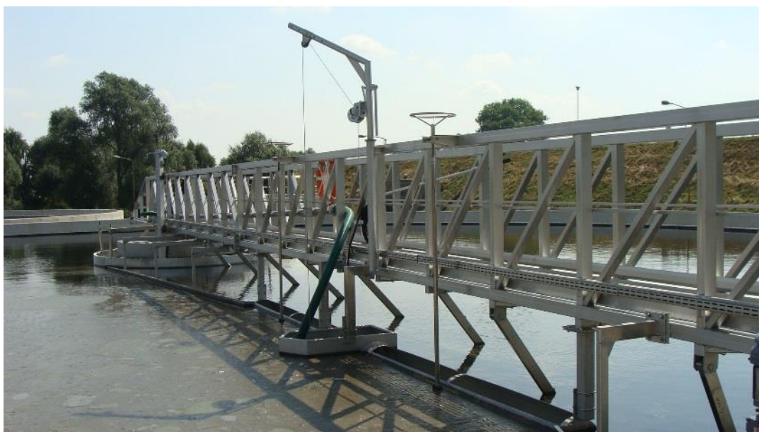
Zdjęcie 2 „Zgarniacz na Oczyszczalni Ścieków w Stargardzie Szczecińskim”.
