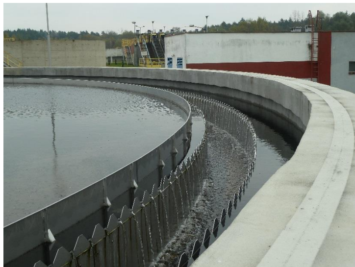
Zdjęcie 10 „Koryto przelewowe na Oczyszczalni Ścieków w Jaworznie”.
