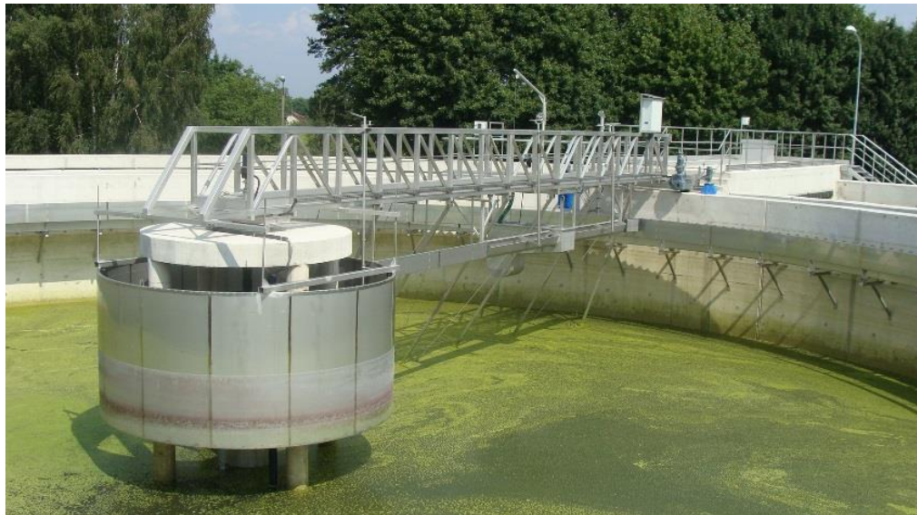
Zdjęcie 3 „Zgarniacz na Oczyszczalni Ścieków w Nowym Tomysłu”.
