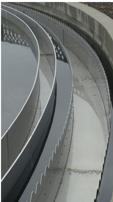
Zdjęcie 3 „Koryto przelewowe na Oczyszczalni Ścieków w Kluczach”.
