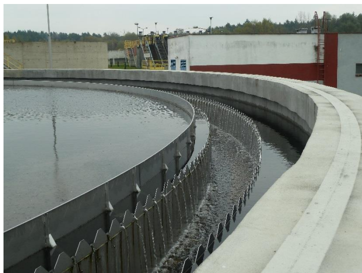
Zdjęcie 4 „Koryto przelewowe na Oczyszczalni Ścieków w Jaworznie”.
